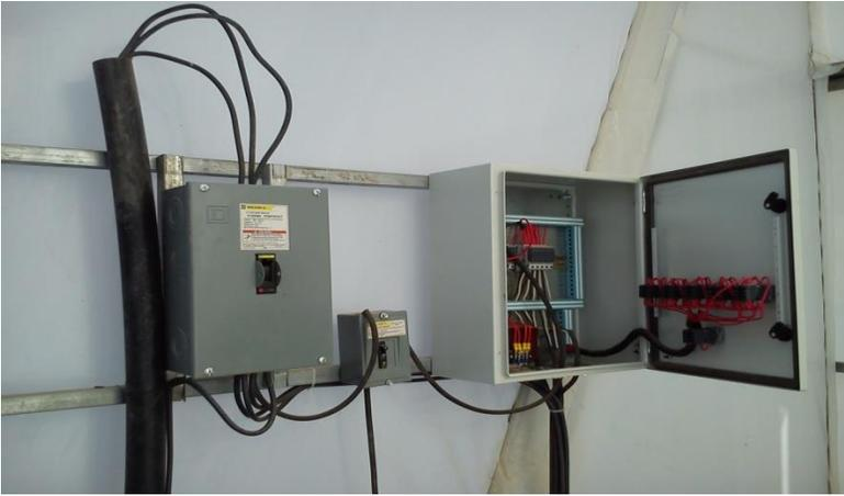
**Figura 21. Tablero de control eléctrico en invernadero.**
