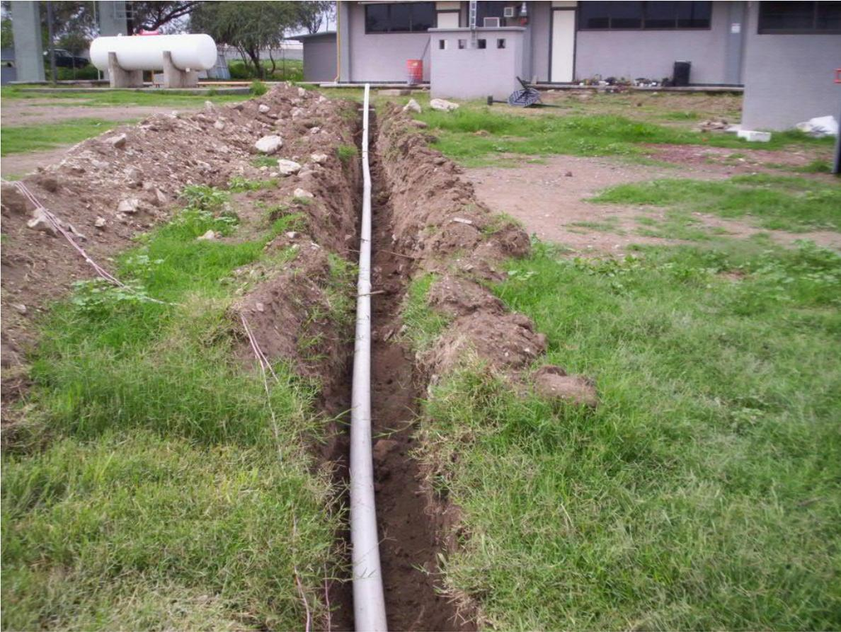
**Figura 26. Excavación de línea principal desde el tanque elevado hacia el invernadero (Suelo tipo A y C)**
