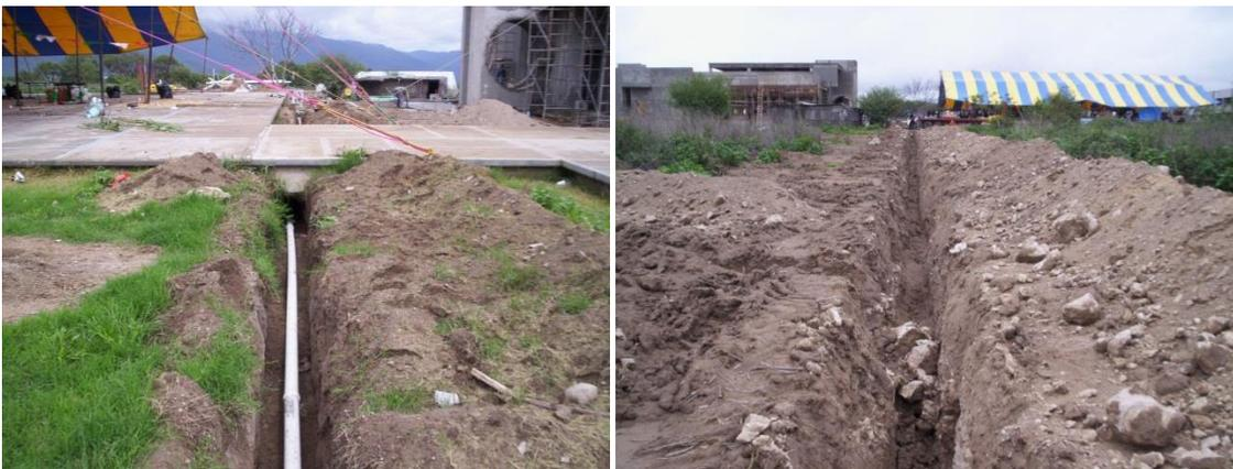
**Figura 27. Excavación principal desde del tanque elevado hasta el invernadero (Suelo tipo A y C)**
