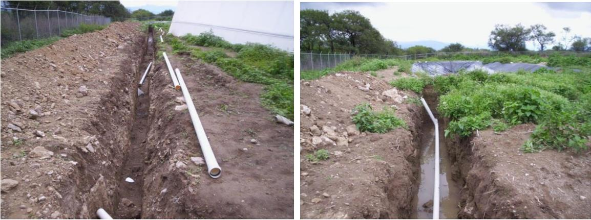
**Figura 28. Excavación correspondiente al tramo del invernadero a la olla de agua (Suelo tipo A)**
