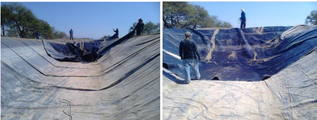
**Figura 47. Colocaciones de la membrana plástica.**
