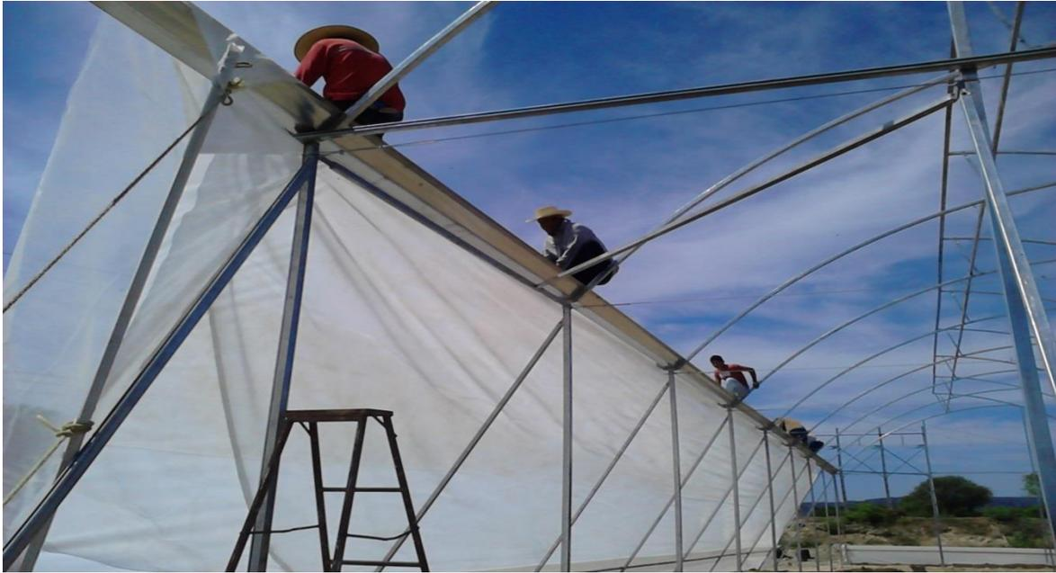
**Figura 8. Colocación de cubierta plástica (faldón lateral).**
