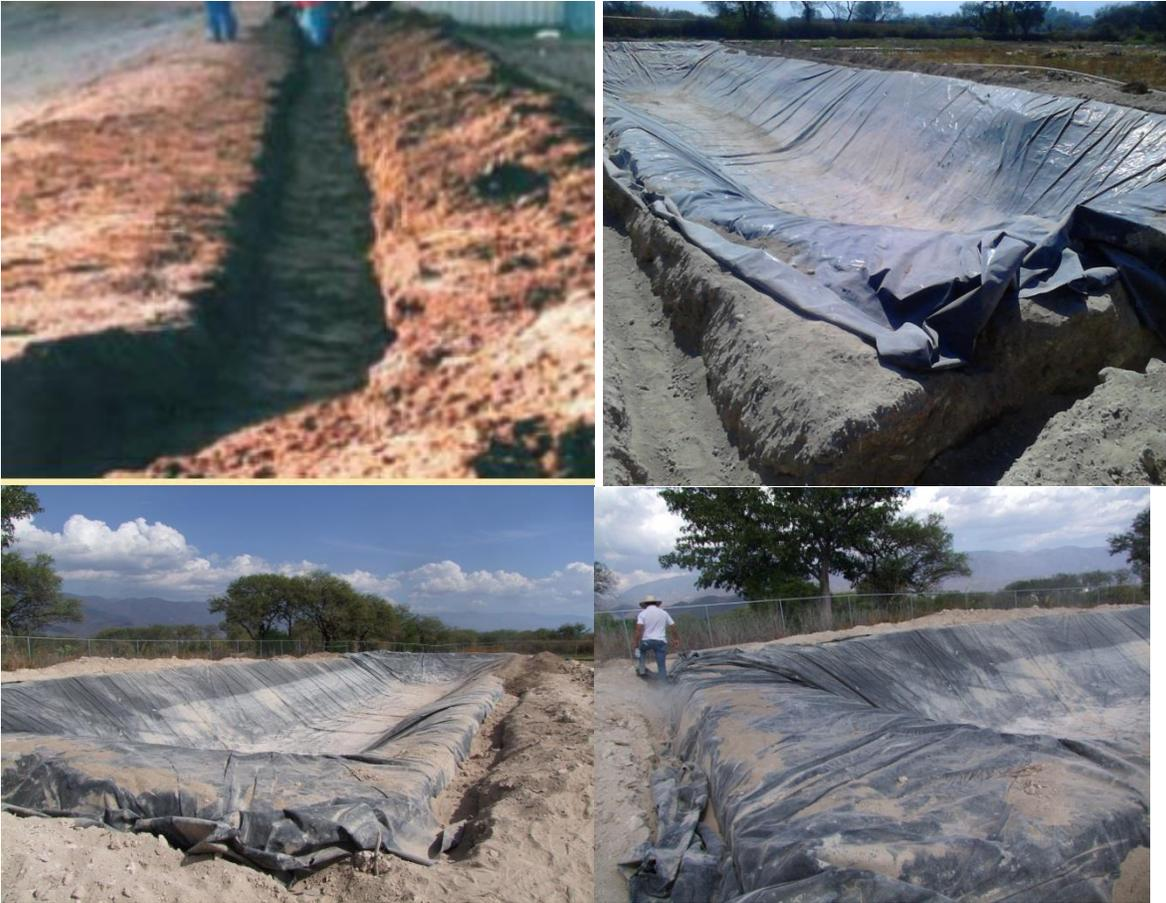
**Figura 44. Excavación para el anclaje perimetral de la geomembrana**
