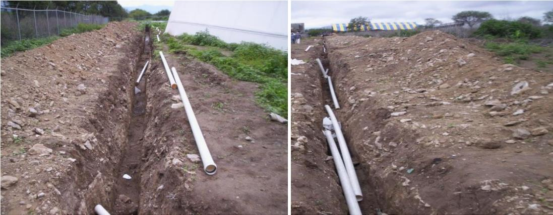
Figura 32. Colocación de tubos PVC en la zanja excavada.
