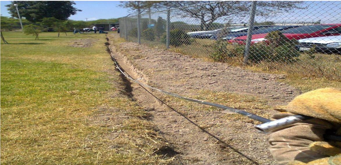
**Figura 18. Introducción del cable de uso rudo a la manguera de 2 pulgadas.**
