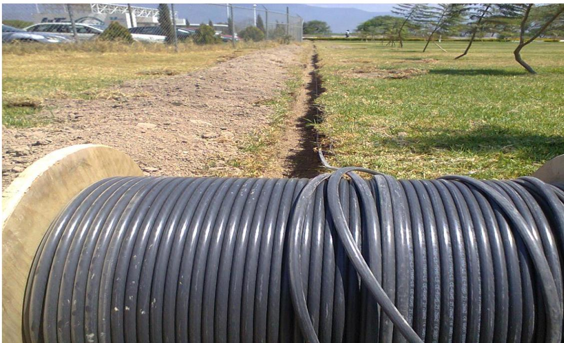
**Figura 15. Tendido de cable rudo**
