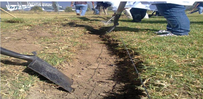
**Figura 17. Inicio de rascado de hoyo para cable eléctrico**
