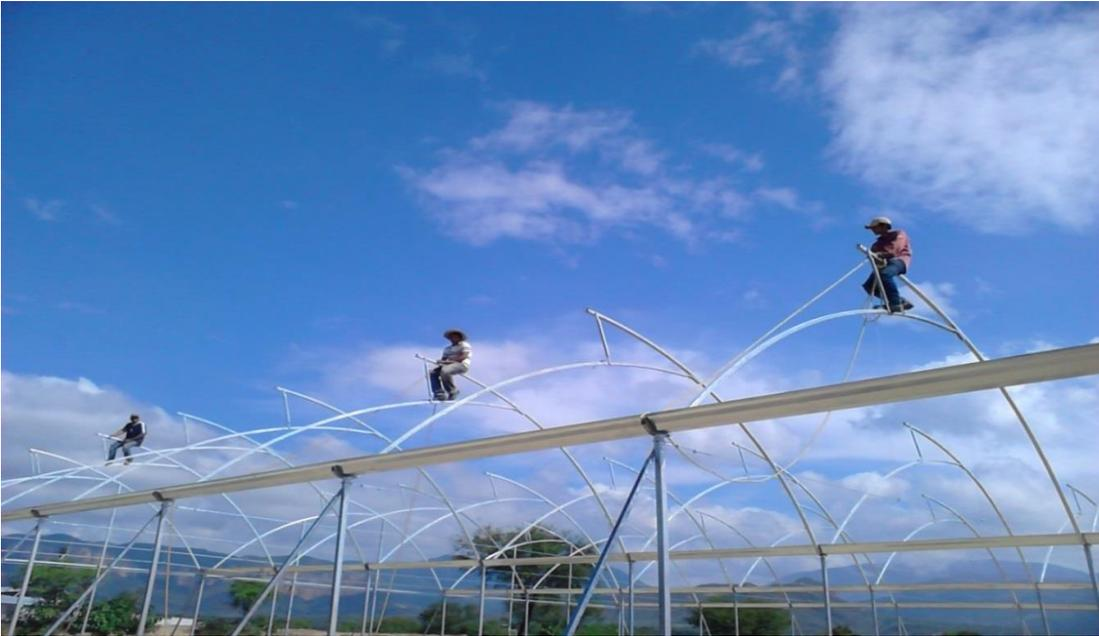
**Figura 7. Ensamble de canalones.**
