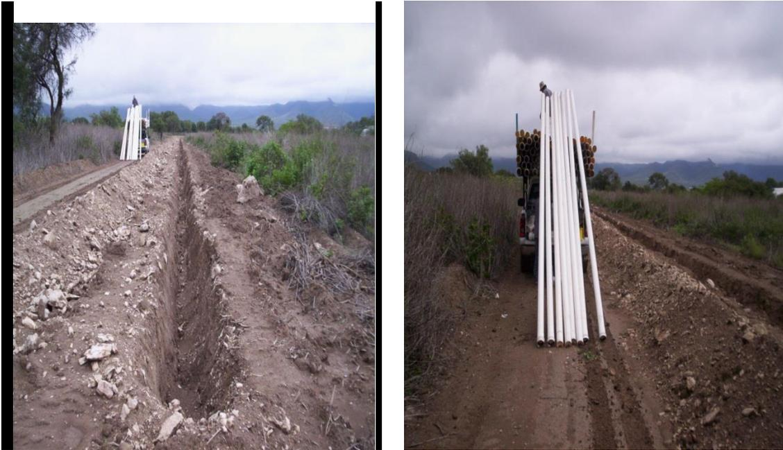
**Figura 31. Traslado de la tubería PVC a la red de excavación.**
