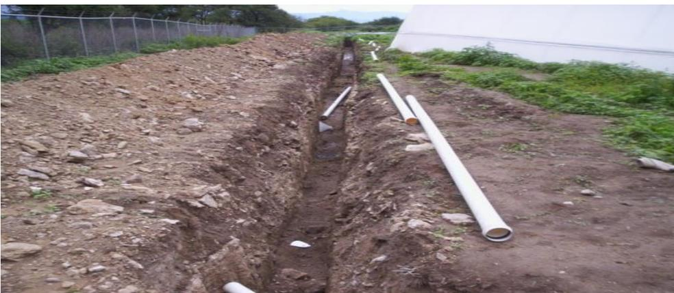
**Figura 64. Colocación y distribución de tubos PVC en la zanja excavada.**
