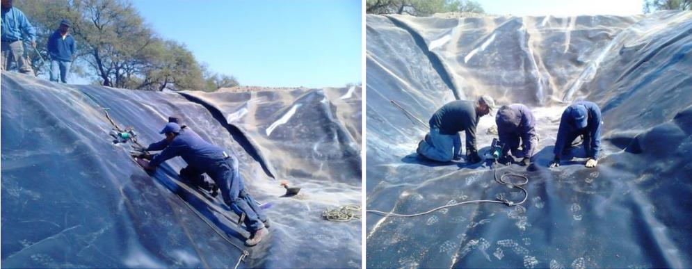
**Figura 48. Verificación de puntos de unión de la membrana plástica.**
