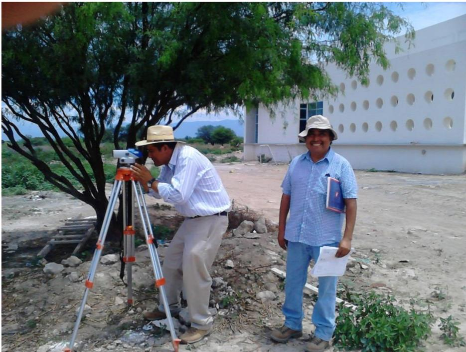
**Figura 23. Trazo y nivelación para la excavación**
