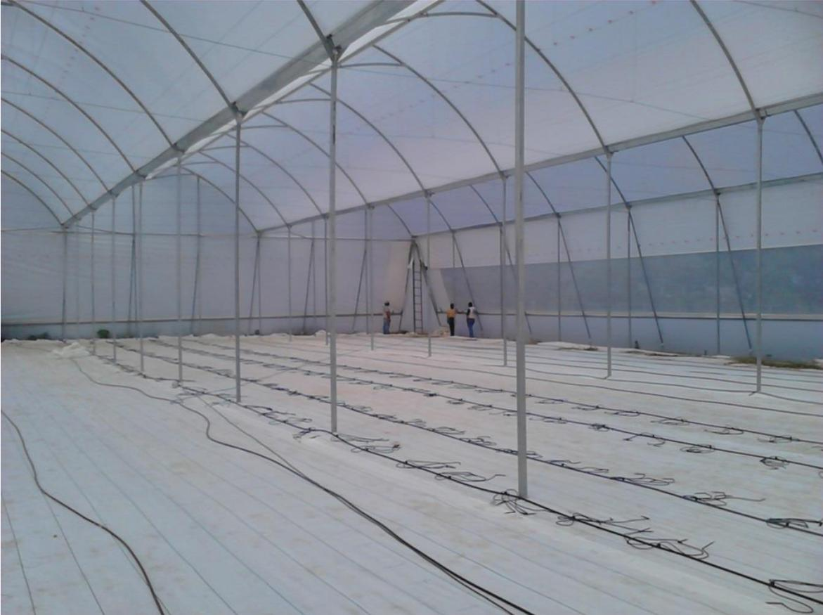
**Figura 12. Tendido de manguera y colocación de emisores.**
