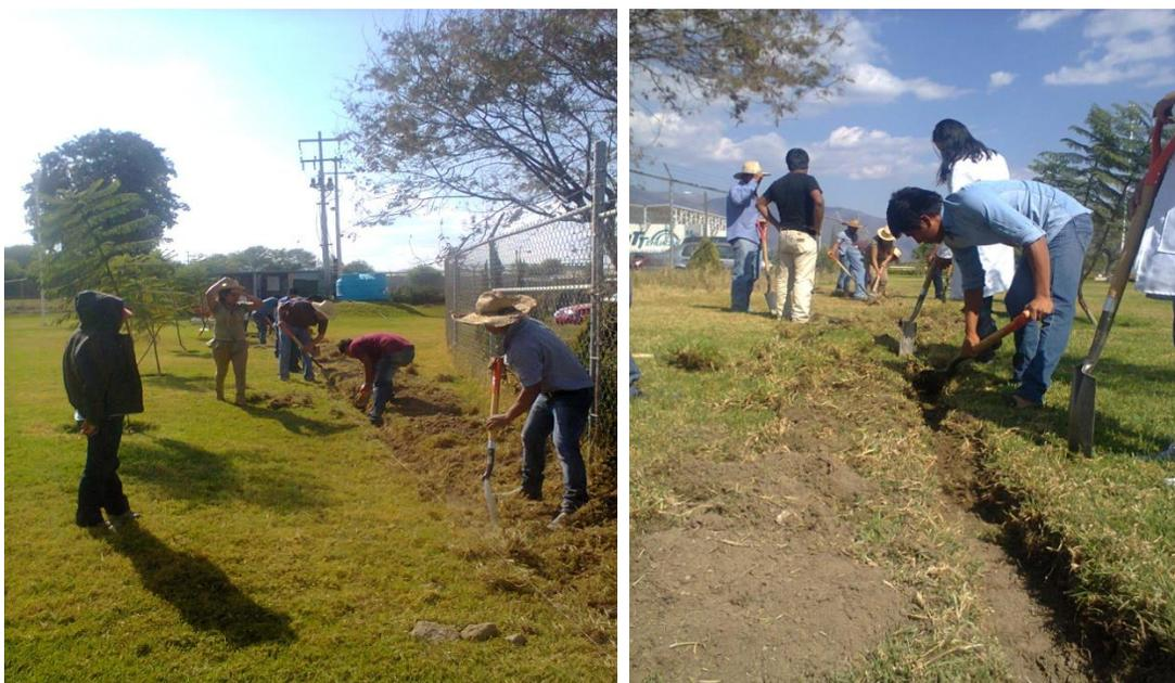
Figura 13. Excavación con el apoyo de los alumnos en la instalación de la red eléctrica
