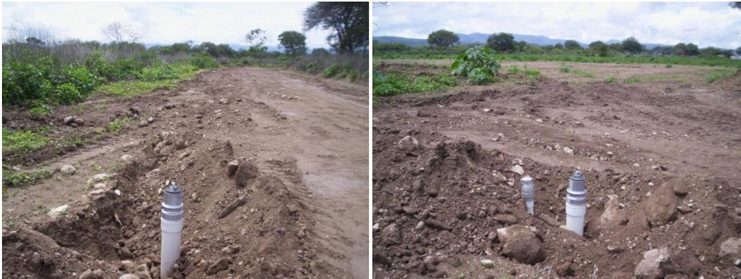
**Figura 39. Hidrantes instalados en el trayecto hacia el campo de futbol.**
