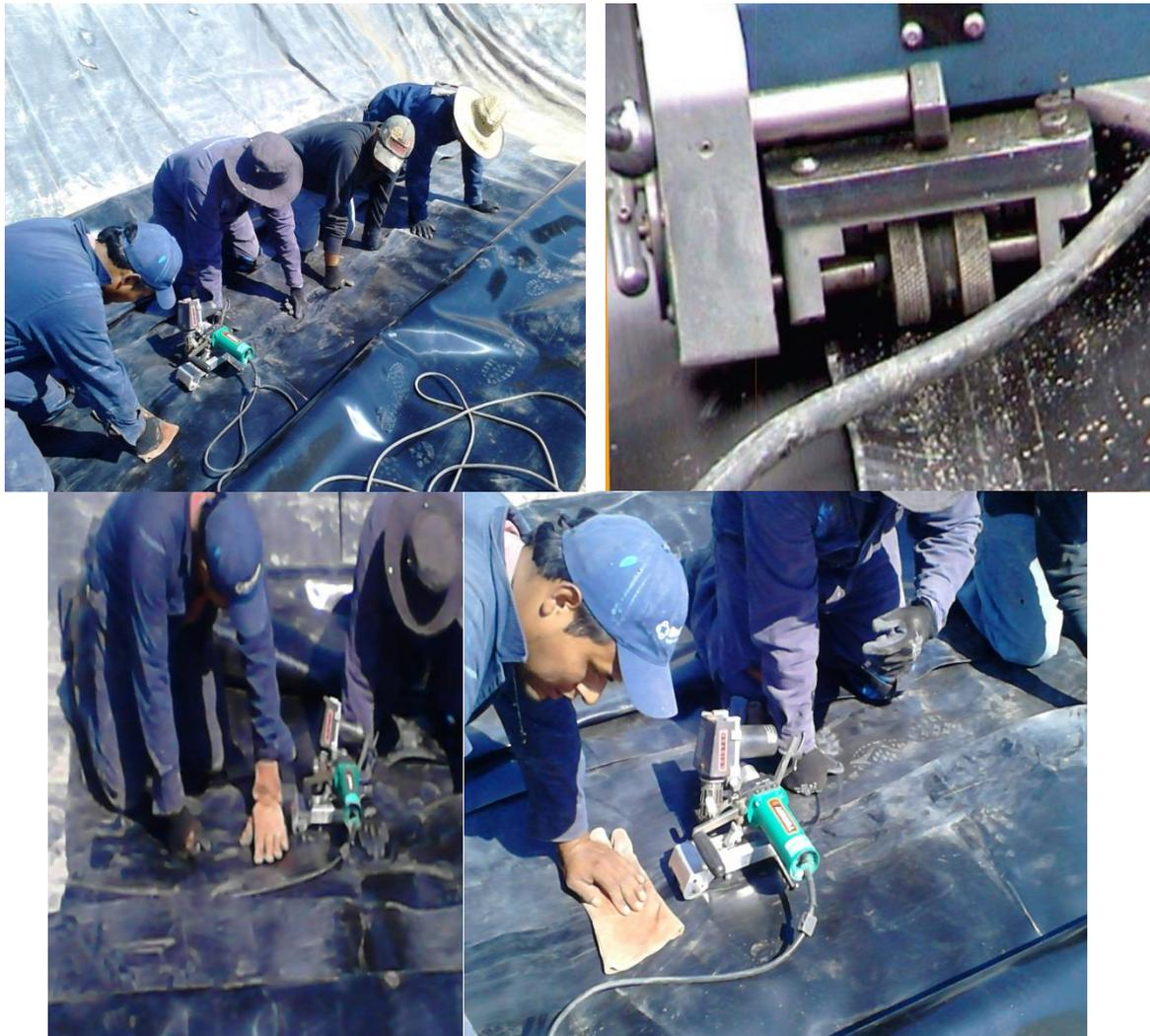
**Figura 45. Unión de pliegues de membrana plástica y equipo para sellado.**
