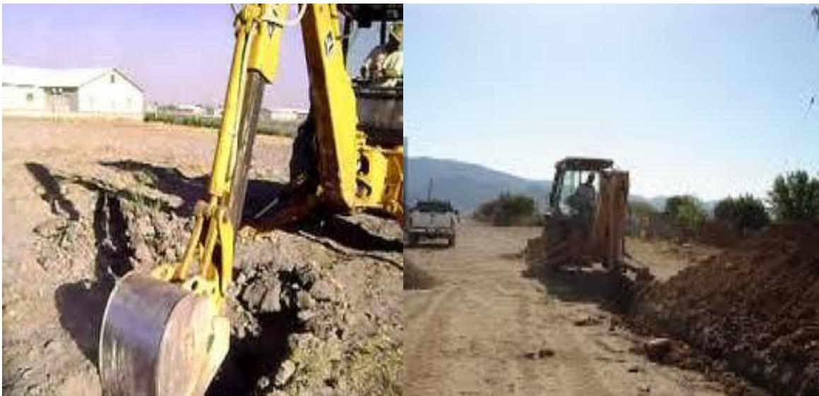
Figura 24. Excavación de la zanja
