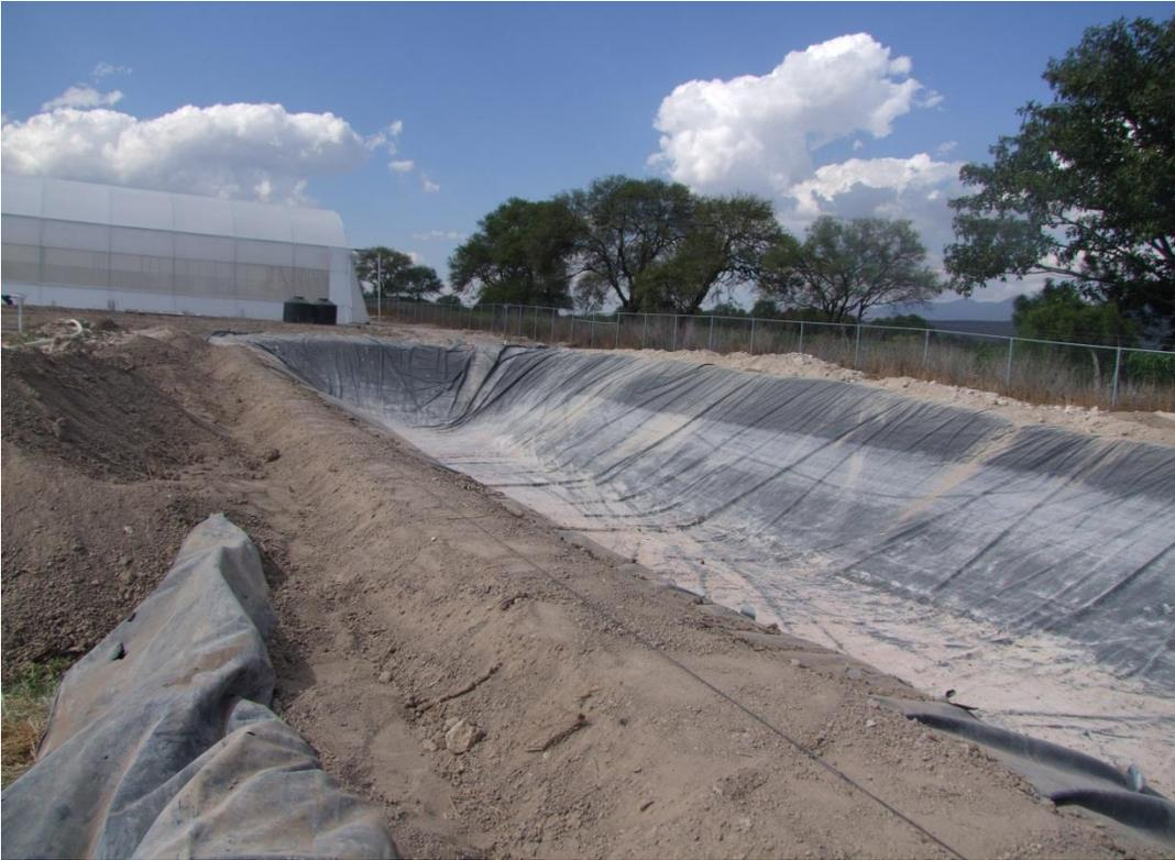
**Figura 46. Terraplén adecuado para colocación de la membrana plástica**
