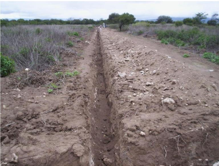
**Figura 29. Zanja excavada tramo en dirección a campo de futbol (suelo tipo C).**
